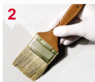
APLIQUE SELLADOR FIJADOR
